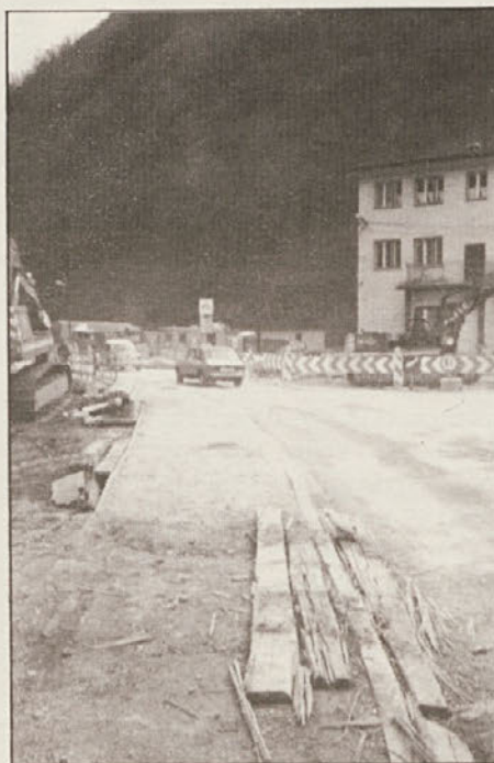
Gradnja križišča Sušnik, dom Zasavje bodo v maju podrl
