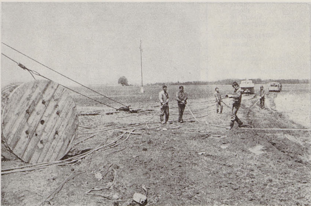
Montaža 400 KV daljnovoda
