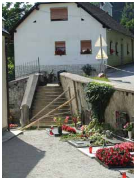
Oporni zid pri cerkvi komaj še drži edino asfaltirano cesto, ki povezuje okoliške vasi
