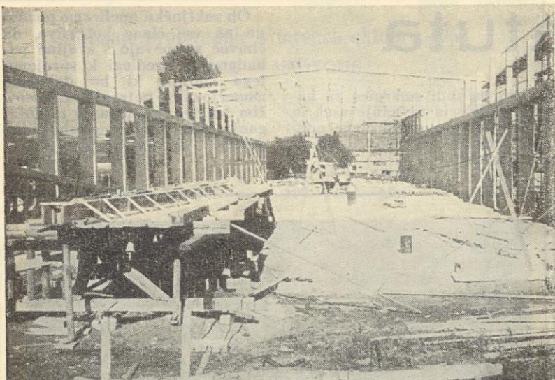
Skladišča papirnih odpadkov v času gradnje... (Foto ing. Miha Svetlin)
