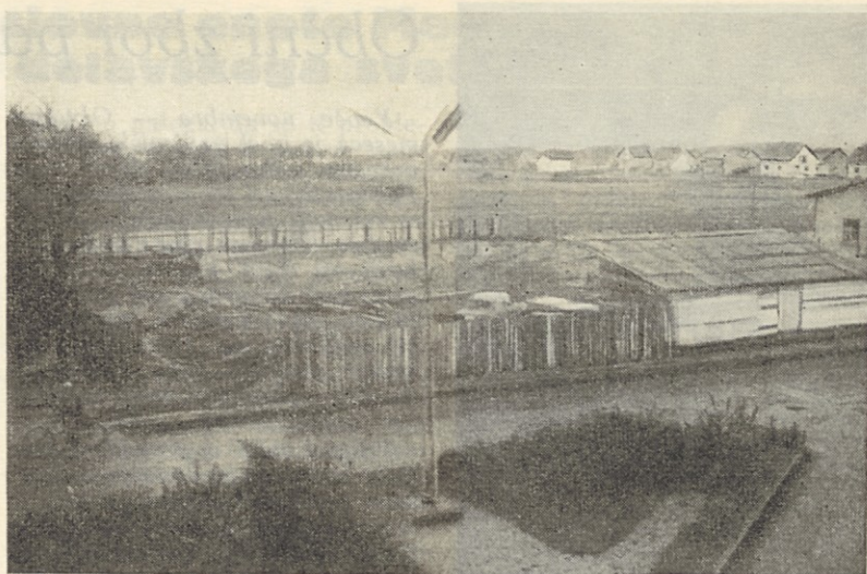
Zdaj pa verjamemo, da bo! (Pogled na gradbišče poslovne stavbe)
