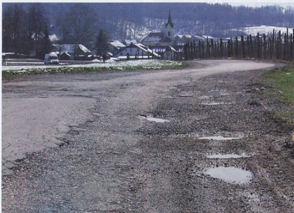
Rekonstrukcija ceste Valburga - Trboje naj bi se začela še letos. Zanj je namenjenih 30 milijonov, kar pomeni ureditev 400 metrov dolgega odseka. / Foto: Maja Bertoncelj
