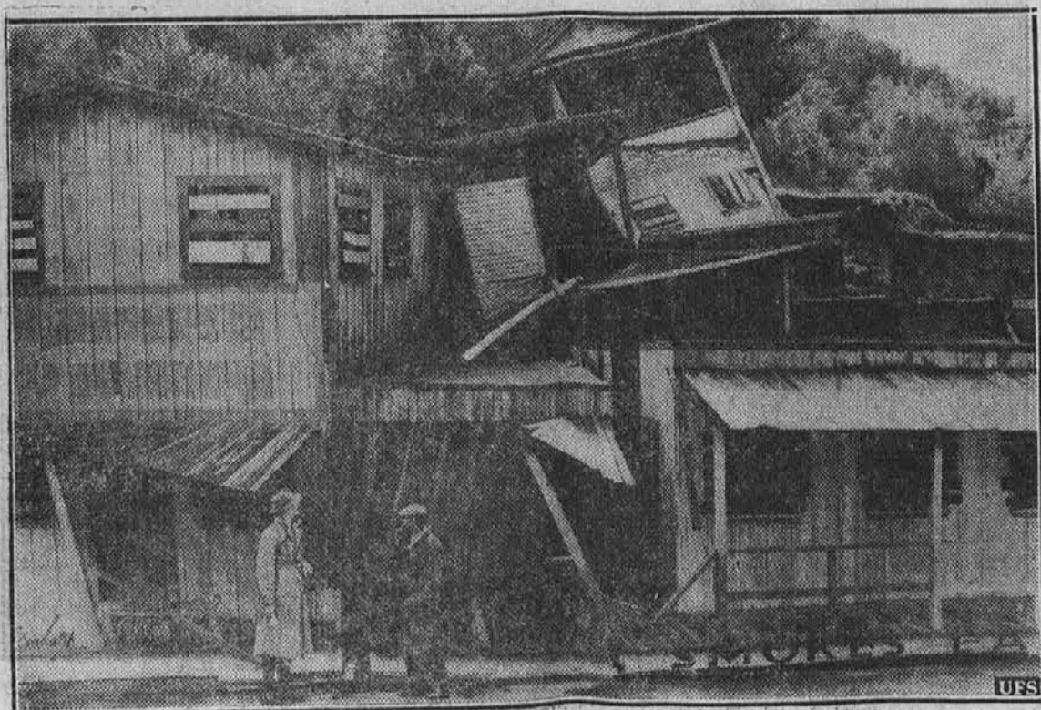
V Topango kotlini blizu Los Angelesa se je vsled neprestanega deževja sesula zemlja, na kateri je stala ta hiša. Hiša je zdrsnila v dolino in se sesedla na kup.
