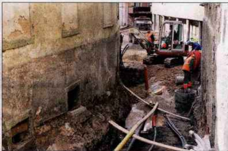
Zadnje letošnje obnove komunalnih napeljav potekajo v Čevljarski ulici.
