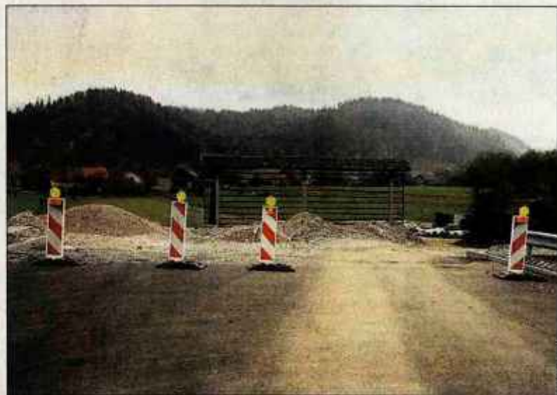
Dolej sta zgrajeni navezovalni križišči za poljansko obvoznico, vse ostalo pa še čaka.
