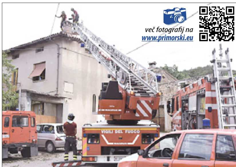
Gasilci so s strehe hiše Tinetovih odstranjevali nevarne strešnike
