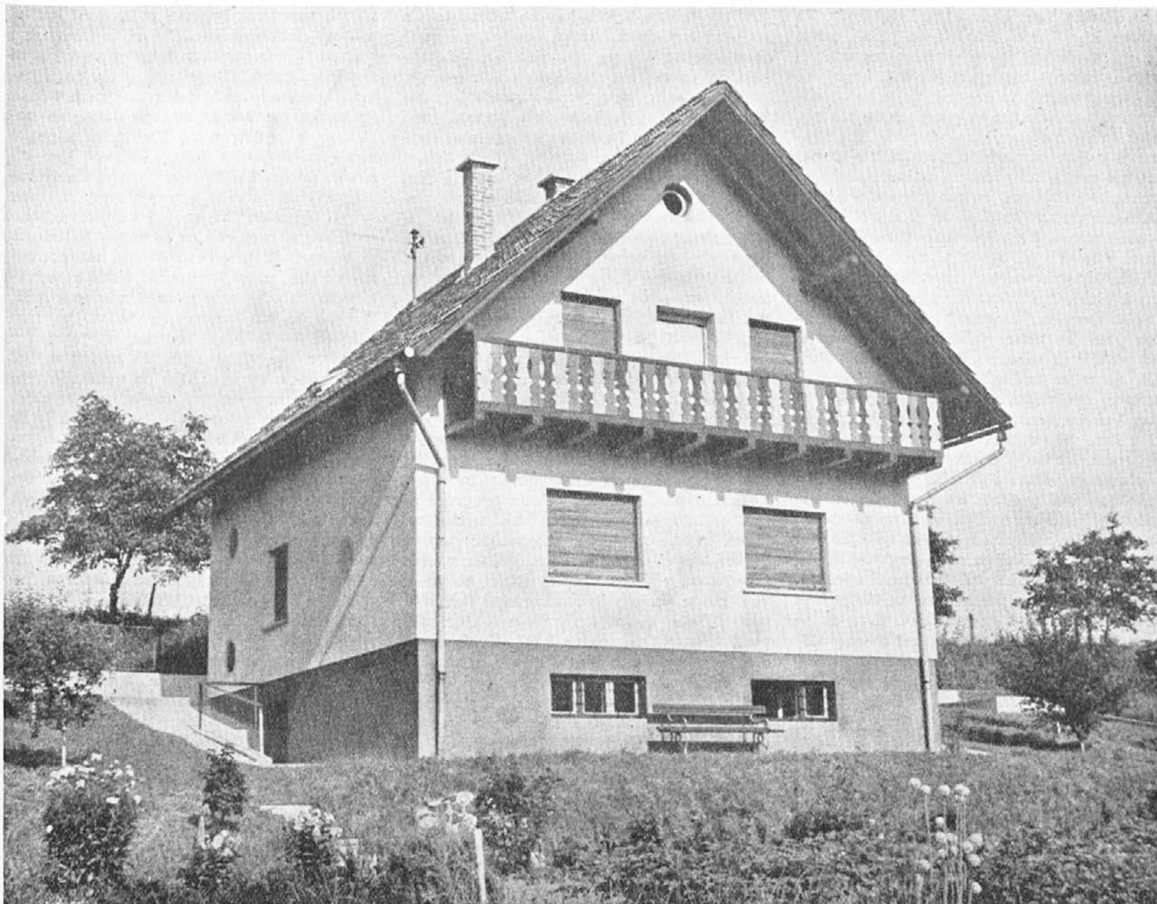
Nekako takšne oziroma tisočkrat lepše bodo tiste hišice na obronku Prežihovega vrha (glej »Koroški fužinar« št. 12a 1962). Okoli šestdeset jih je tam označenih in vse enake — koroške »kašte« z balkoni. Kakih petindvajset graditeljev je že pridno na delu, stanovanjski sklad občine pa pomaga, kolikor doseže. Ob vsej želji srečne gradnje in dograditve pa bi s strani »izkušenih« le izdali, da balkoni od blizu nikoli niso tako simpatični kot morda od daleč. V naših krajih je vsaj že po osem mesecev zanič vreme in tedaj so skoro še okna preveč
