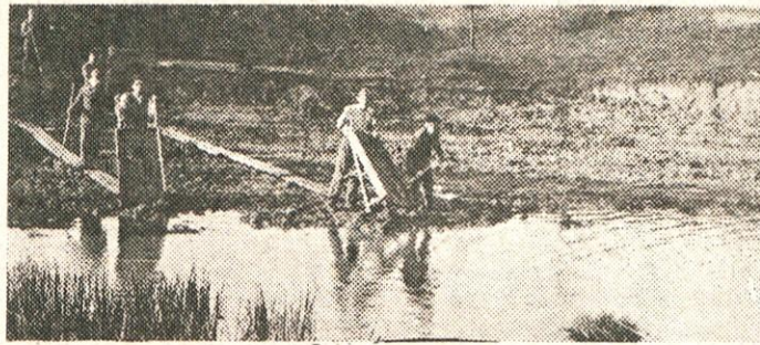
Prva delovna akcija pri izgradnji ribnika
