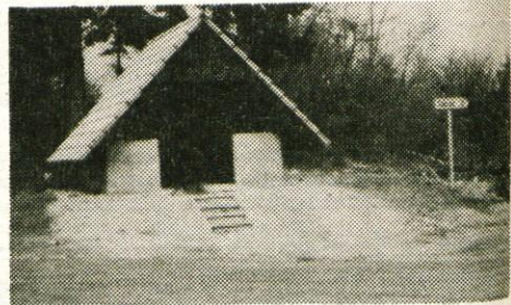
Na Poljani so za prebivalce Sidraža in Lenarta lani zgradili avtobusno postajališče...
