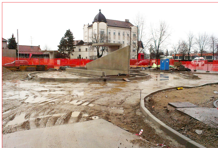
Gradbena dela so v zaključni fazi, končana so v 90 odstotkih, potrebna so še obrtniška, keramična in zaključna dela.
