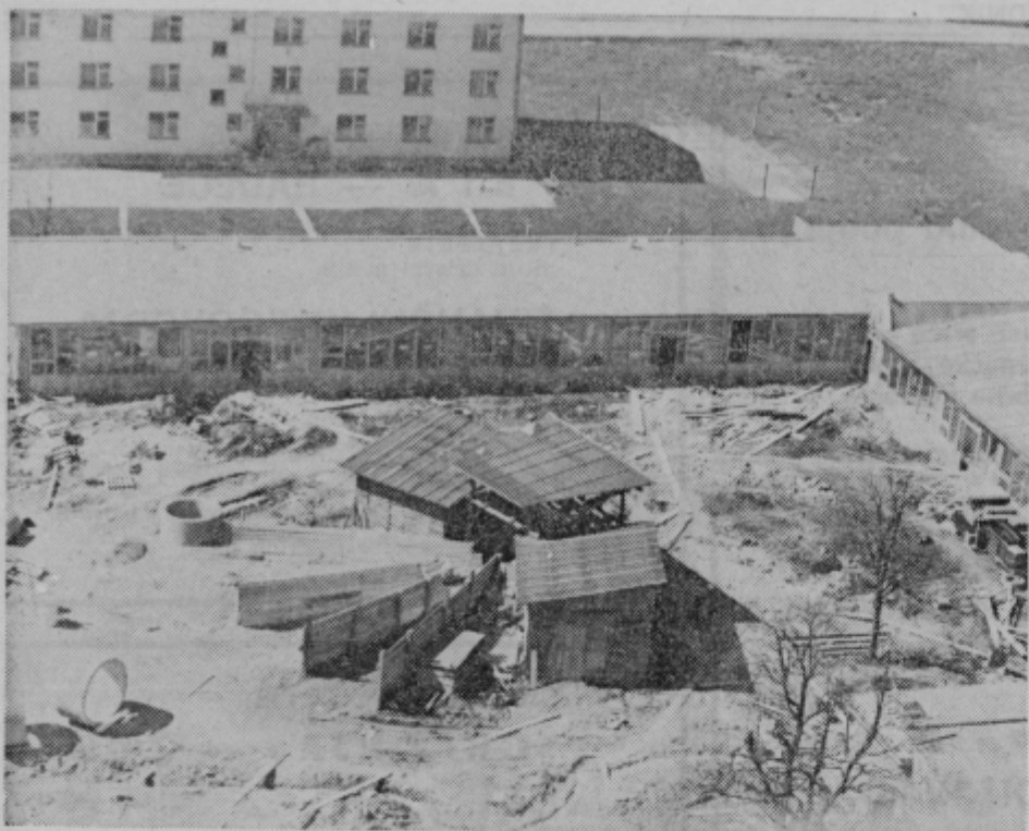
Prvi rezultat samopriskrbe je že dobro viden. Nov otroški vrtec na Hudinji je že dobil svoj obraz. Še malo se bodo po njem zavrteli obrtniki, očistili okolje in že bo tu svečana otvoritev. Prav gotovo hitro in efektno. Upajmo, da bo tako tudi pri preostalih objektih.
