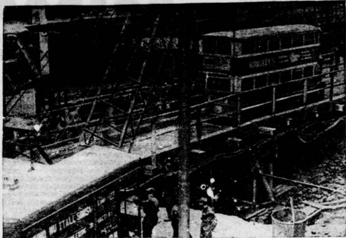
Nemške bombe so povzročile v angleški prestolnici ponekod tako hudo razdejavanje, da so morali preko lijakov na cestah postaviti zasilne mostove za pešce in vozila
