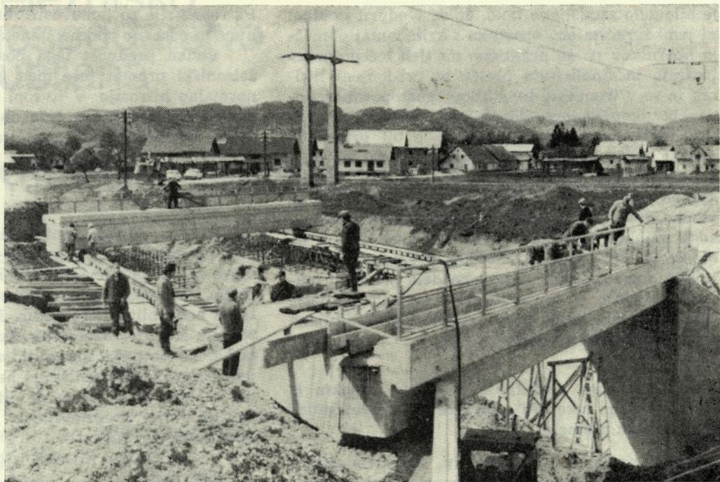
Sl. 5. Gradnja podvoza v Godešiču. Plošča je potisnjena v končno lego, nosilec hodnika bo treba še potisniti
