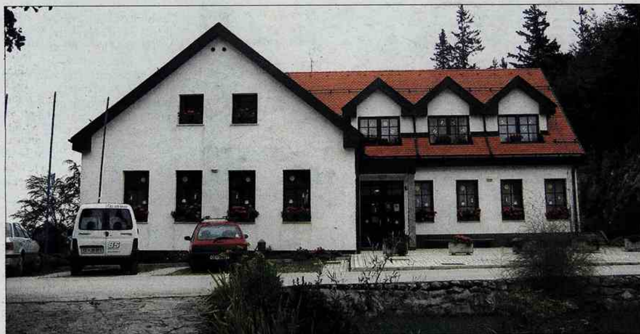
Šola na Paškem Kozjaku so v letih 1996/97 temeljito prenovili in razširili. Odprtja obnovljenih prostorov sta se udeležila celo takratna predsednik države Milan Kučan in šolski minister Slavko Gaber. Danes šola, ki ima urejenih celo več garsonjer za učitelje, žalostno sameva.
