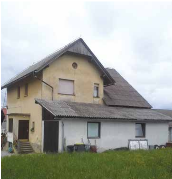
Stavba nekdanje podružnične šole Veliki Osolnik pred obnovo
