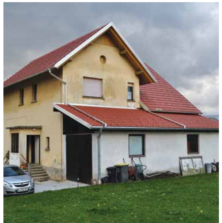
Stavba nekdanje podružnične šole Veliki Osolnik po obnovi
