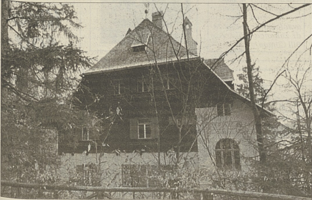
Vila Zlatorog (Vse foto: Boban Plavevski)
