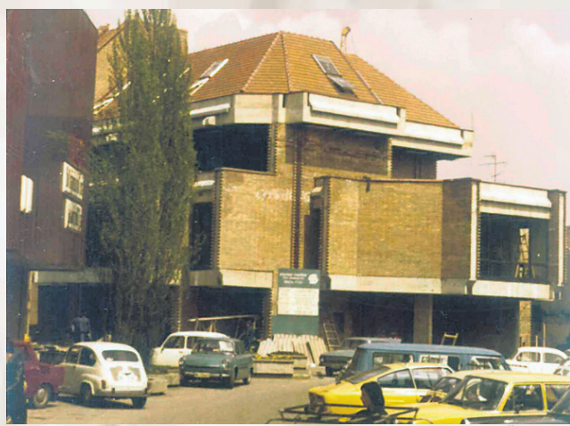
Gradnja objekta Službe družbenega knjigovodstva in Projektivnega biroja v Trstenjakovi ulici.
