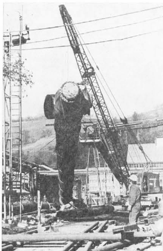
Demontaža plinovoda za generatorski plin
