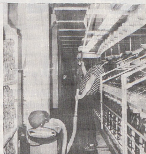
Klemen čisti klimatske kanale z industrijskim sesalcem.
