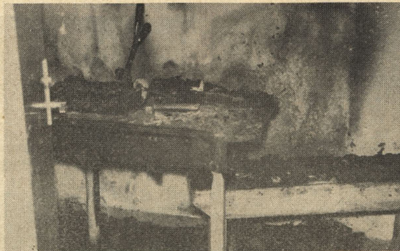
Manjši požar, ki je nastal v kletnih prostorih skladišča, bi se lahko končal bolj tragično
