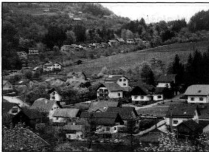
V KS naj bi letos uredili kanalizacijo, v Lajšah pa se lotili izgradnje vodovoda
