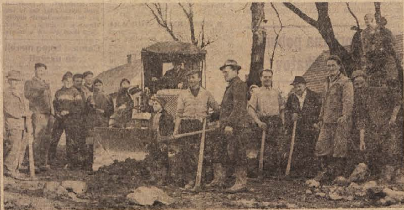
TO JE PRAVI ČAS ZA CESTO! Na Zajčjo goro, priljubljeno izletniško točko Sevnčanov, gradijo domačini 3 in pol km dolgo cesto. S samoprispelkom so zbrali 16.000 din. opravili pa so več kot 3.200 delovnih ur. Upajo, da jim bo na pomoč priskočila tudi občina, saj bi tako bila cesta narejena do 1. maja letos. (Foto: Franc Pavkovič — nagrada za fotografijo tedna).
