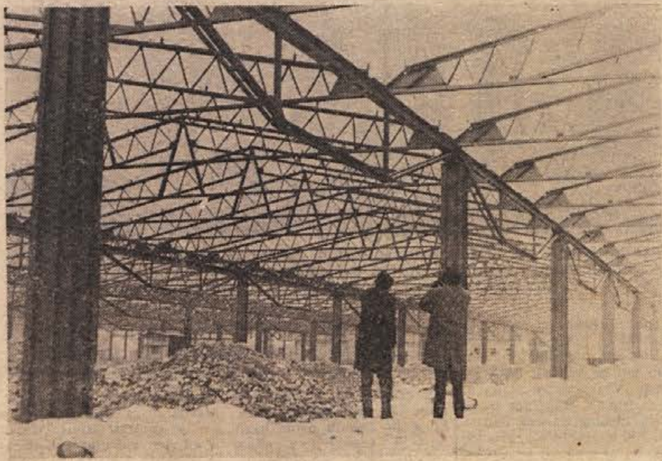
NAJVEČJA TE VRSTE V SLOVENIJI. Doslej največji proizvodni uspeh Kemo-opreme iz Trebnjega: v 120 dneh je bilo narejeno in postavljeno montažno kovinsko ogrodje za okoli 16.000 kvadratnih metrov veliko industrijsko dvorano tovarne Alples v Železnikih pri Skofji Loki. Pri izdelavi so uporabljali točkasto varjenje hladne pločevine. Novi način omogoča za dobro tretjino cenejšo gradnjo in še enkrat krajši čas izdelave. (Foto: M. Legan)
