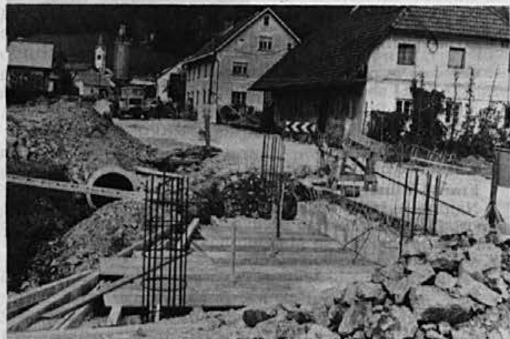
Gradnja pločnikov proti Županu se uspešno nadaljuje
