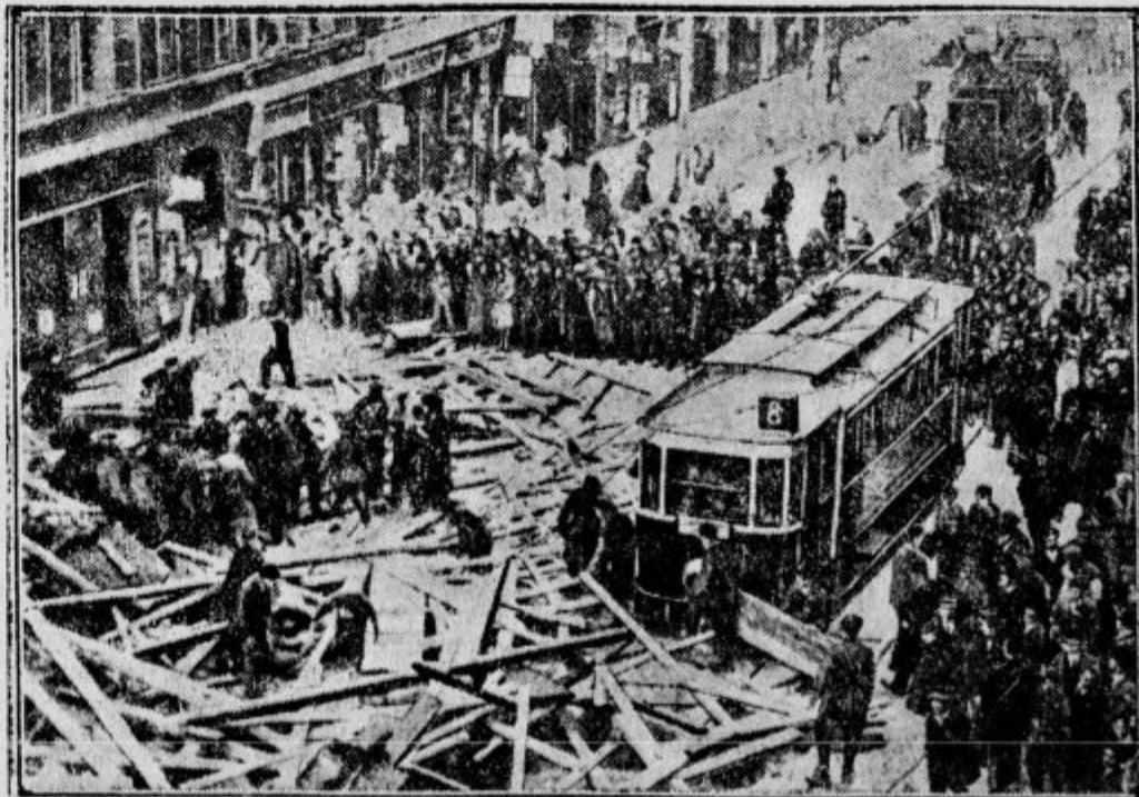
Škofja ulica v Pragi z razvalinami nove sedemnadestopne hiše.
