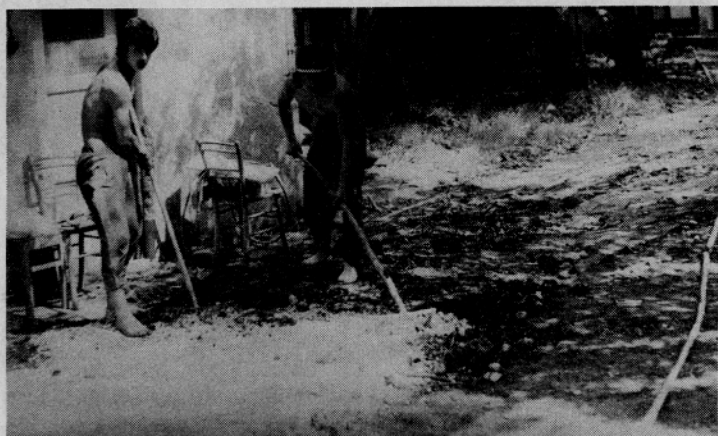
Izravnavala trase nove kanalizacije je terjala dosti nepredvidenega dela
