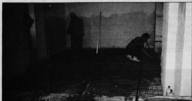
Takšen je bil prostor prodajalne med izvajanjem gradbenih del. Foto: Jože Troha, izvajalec del
