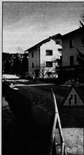
Jezerska ulica pa na asfaltno prevleko še vedno pohlevno čaka
