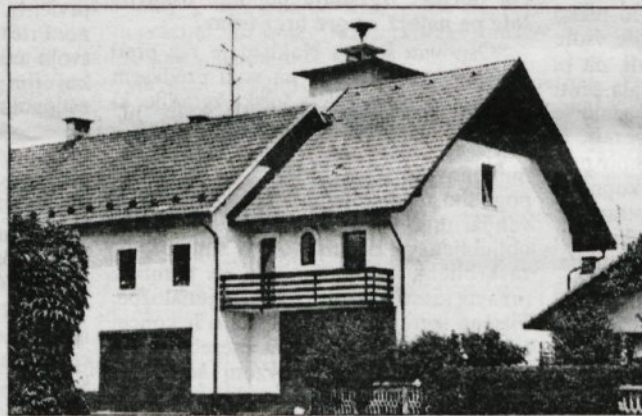
V gasilski dom in prizidek so nakelski gasilci vgradili na tisoče delovnih ur.
