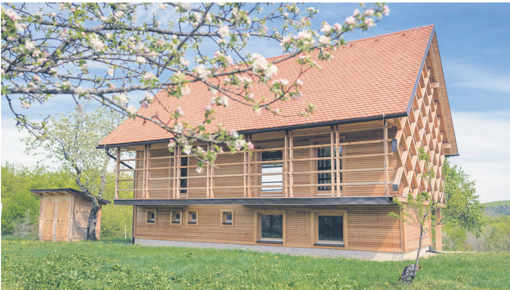
Prihodnja lesena stavba v centru visokodebelnih travniških sadovnjakov na Gradišču pri Podsredi (Foto: Kozjanski park)
