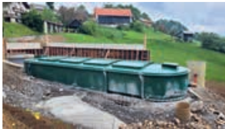
Tu se je že videlo kako bo čistilna naprava umeščena v prostor.
