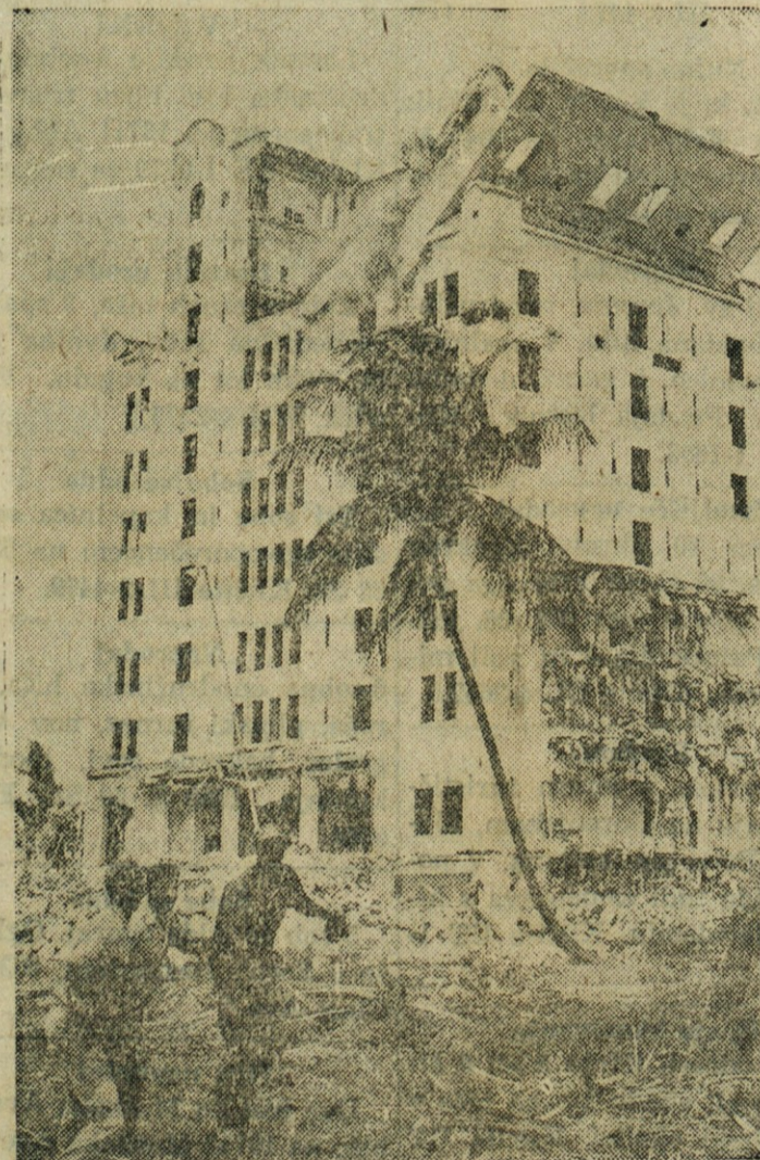
STENE SE RUŠIJO — Delavci so začeli rušiti tale hotel v Miami Beach, da bodo napravili prostor za novega, modernjšega.
