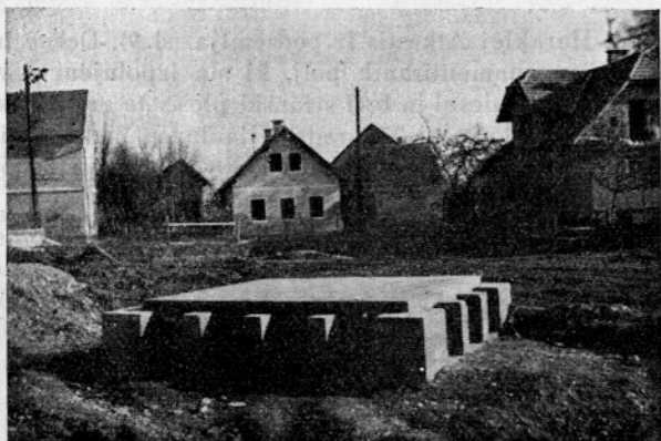
Sl. 7. Temelj I, zaščiten
