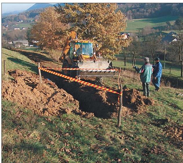
Foto: SM Javni vodovod od centra Žetal do Čermožiš bo zgrajen najkasneje do konca aprila naslednje leto.
