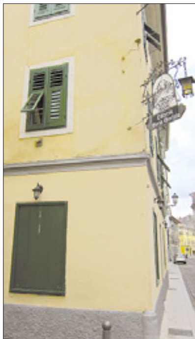
Stavba nekdanje gostilne Pri Maksu
