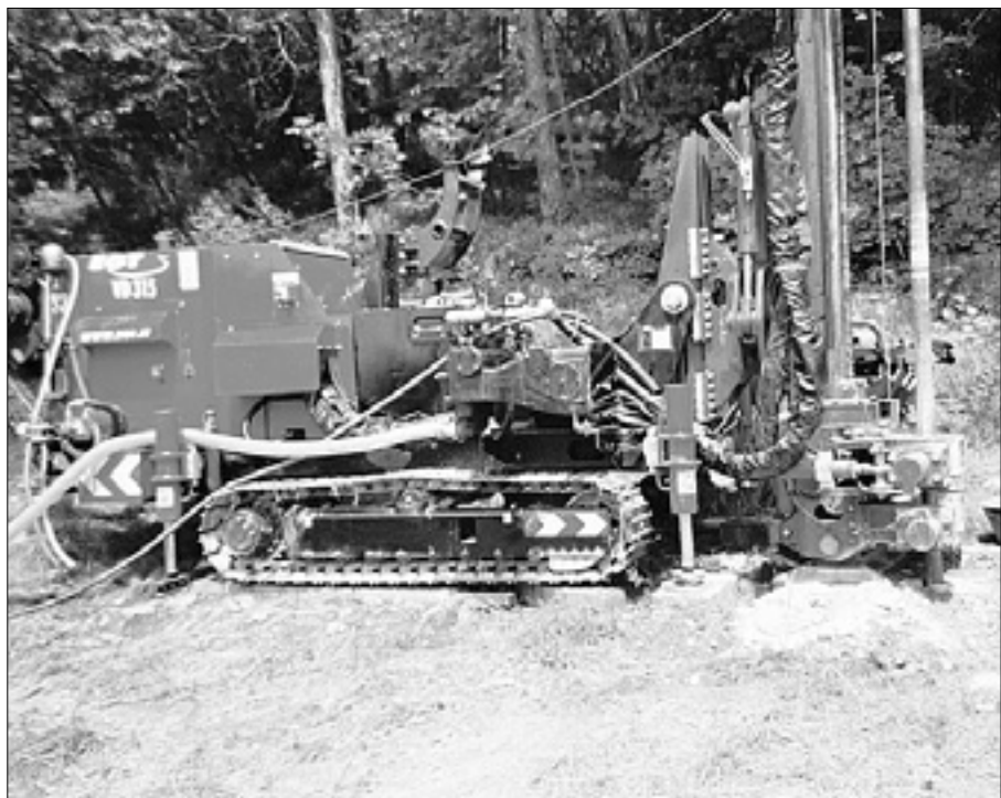
Vrtalni stroj za sondiranje terena v gozdu med Križem in Prosekom
