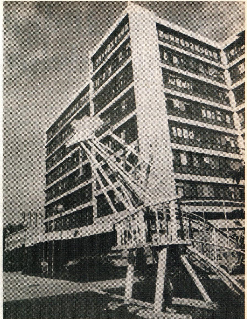
Upravna stavba Podravke, ki zaposluje samo v mestu 2500 ljudi.
