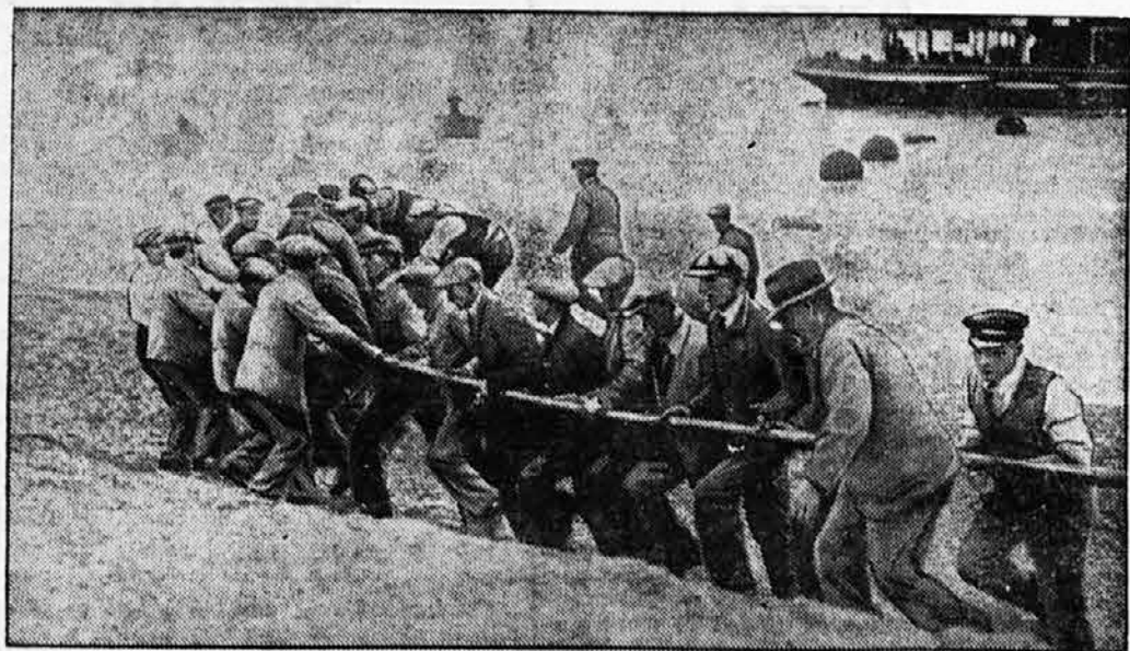
Polaganje telefonskega kabla Nemški in angleški delavci polagajo v Rokavskem zalivu telefonski kabel, ki bo vezal Boulogne in St. Sandgate in ki ga je dobavila Nemčija na račun vojne odškodnine.
