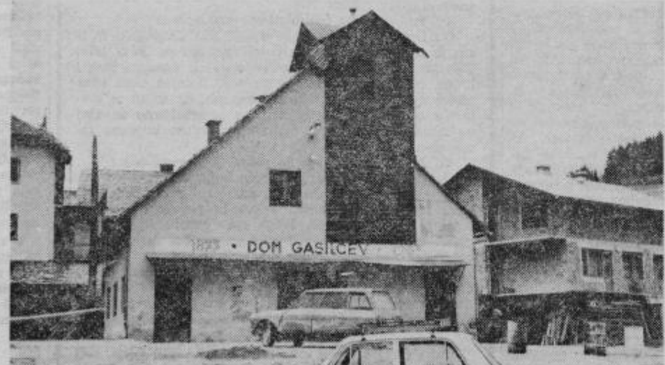
Gasilski dom Vitanje, ki so ga 12. februarja letos pričeli rušiti, da bi na njegovem mestu zgradili novega.
