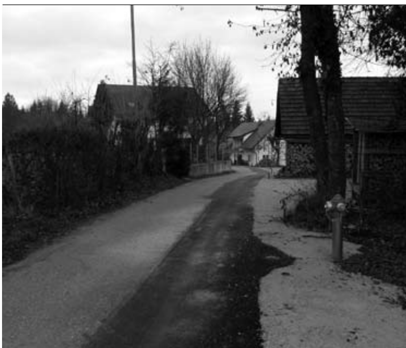
V oktobru je bil zgrajen nov sekundarni vodovod v Zapotoku (mali stan) v dolžini 183 m.
