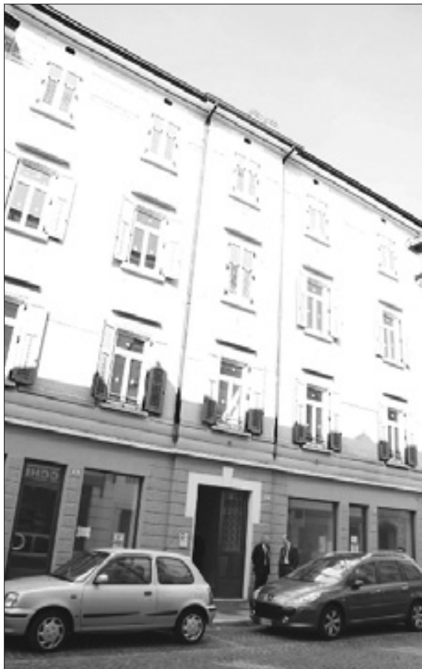
Obnovljena palača v Gosposki ulici v Gorici (levo) in predaja ključev novim stanovalcem (spodaj)
