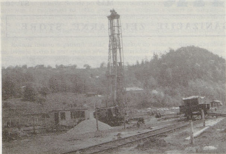
Zabijanje pilotov za temelje hale za žlindro
