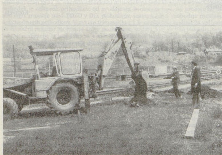
Izkop prvih temeljev hale za žlindro
