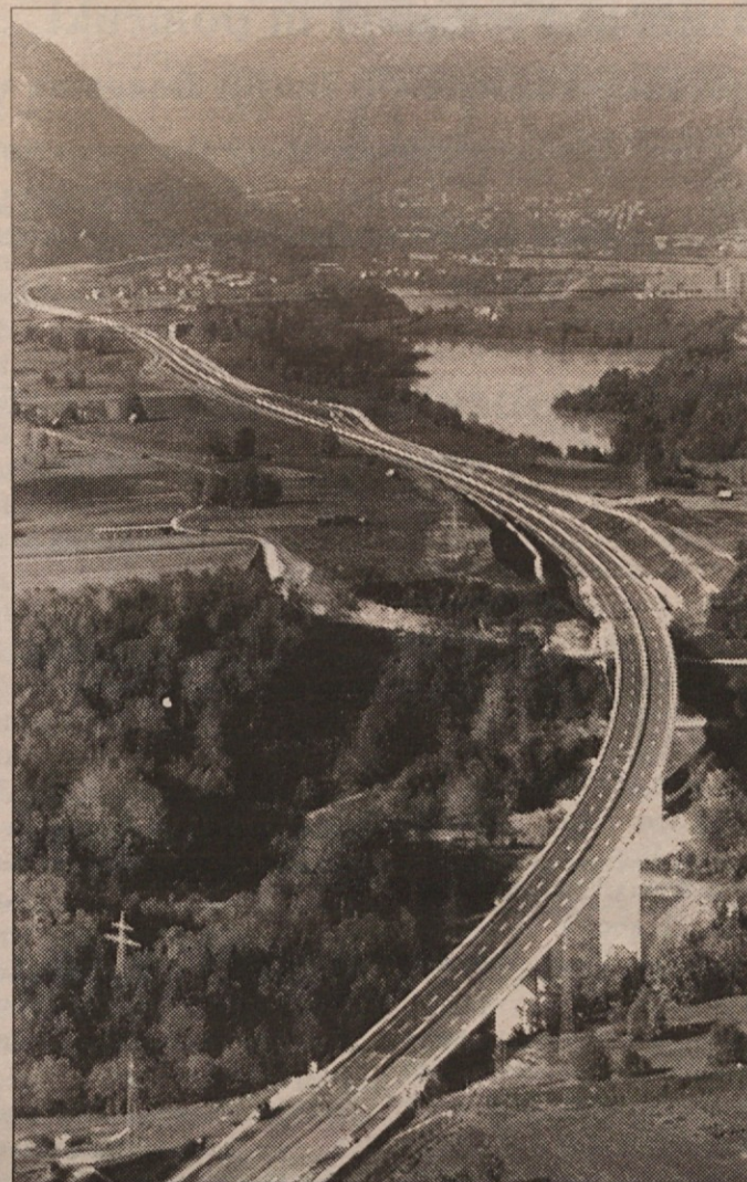
Od viadukta čez Savo v Mostah (na sliki) se avtocesta vije proti Jesenicam. Obide jih spretno in tehnično zelo zahtevno stisnjena pod Mežaklo in Savo in se konča na ploščadi pri Karavanškem predoru.
