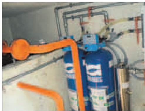
Pogled v »notranjost« butajnovskega vodovoda
