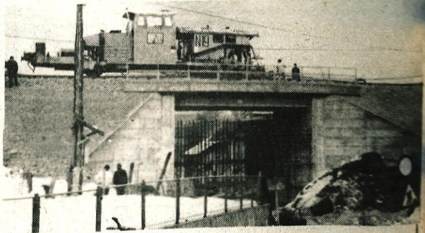
Jesenice — V petek, 21. novembra, so delavci železnice odstranili zasilne nosilce za most Podmežaklo, kjer so zgradili novega in večjega. V kratkem bodo pod njim uredili cesto, tako, da bodo tu skozi odsej lahko vozili tudi avtobusi. Delavci TOZD SAP Viator Jesenice namreč predvidevajo, da bodo tu skozi upeljali tudi lokalno progo za avtobuse. — Foto: B. B.
