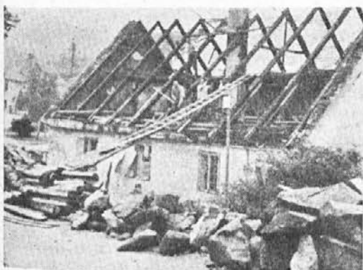
»Pokarca« v Mežici je torej šla. Podrli so jo letos zaradi regulacije potoka Sumca, z obratovanjem pa so nehali seveda istočasno s fužinami že leta 1916. Zgradba je bila stara okoli 200 let in je služila za čiščenje in zavijanje oziroma pakiranje izdelkov tamkajšnjih fužin. Zadnji posnetek je napravil ter nam ohranil zanimiv spomin Matevž Nagernik iz Mežice
