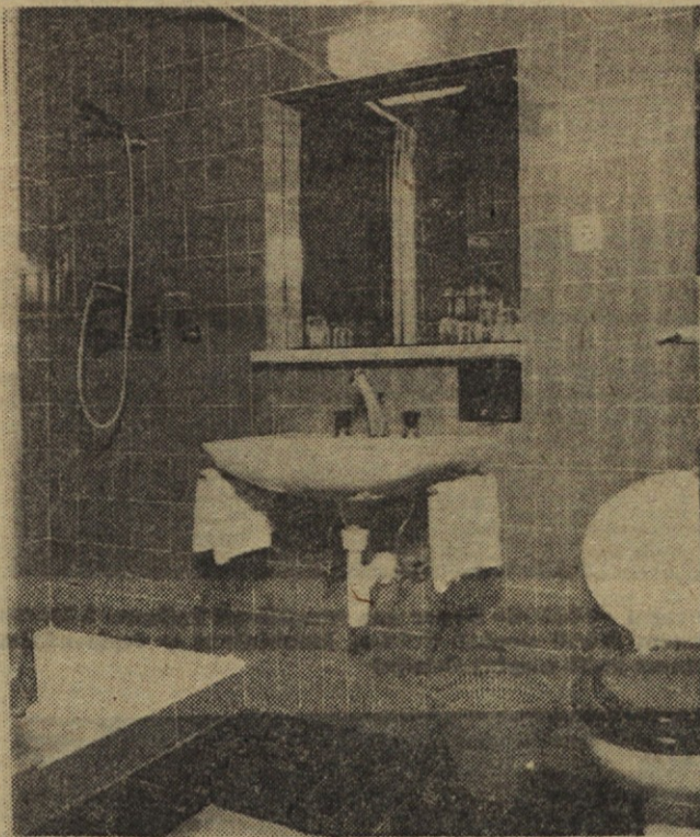
Vodovodna instalacija in sanitarni prostor s pršno kabino in mehaniko v ljubljanskem hotelu »LEV«
