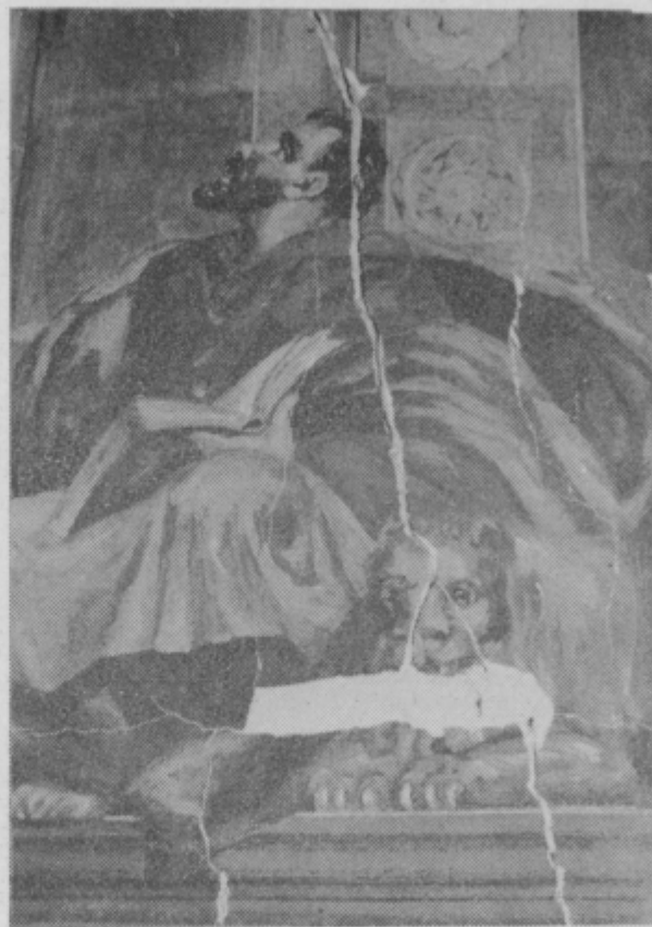
Del freske graškega slikarja Matije Schifferja, ki je končal fresko na steni apsida 1813. leta. Freska je v svojem srednjem delu močno poškodovana in to v globino stene, medtem, ko so razpoke ob robu slikarije bolj površinske in na srečo niso prizadele obrazov na feskci.
