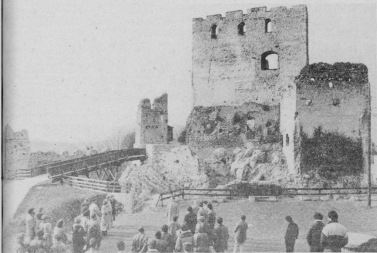
Če se je na celjskem gradu nekaj naredilo, kar bo gotovo povšeči Celjanom in turistom, ki ga bodo obiskali. Rekonstrukcija so srednjeveški most, ki bo povezoval notranji in zunanji del gradu, hkrati pa bo zelo dobro služil gostincem, da bodo lažje opravljali svoje delo. Zavod za spomeniško varstvo v Celju, ki je dela na celjskem gradu strokovno vodil, je tako opravil eno med načrtovanimi nalogami. (Foto: EDI MASNEC)
