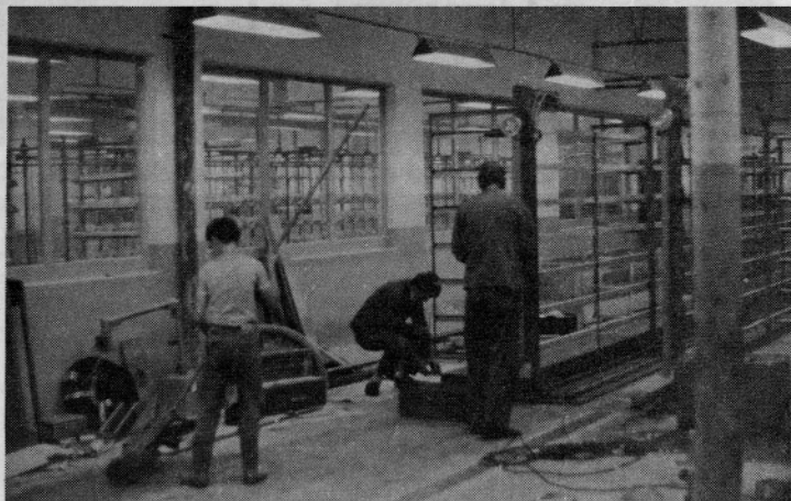
Montaža cevčnice za saško snovalo.
